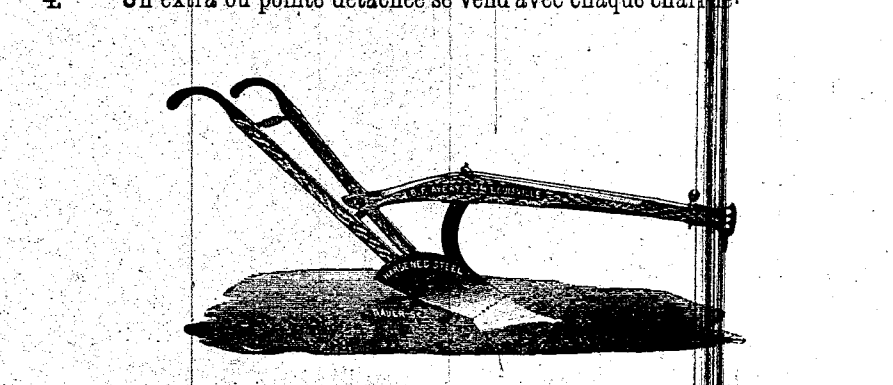
CHARRUE No C. O., TRANCHANT EN ACIER DE 9 1/2 POUÇES.
